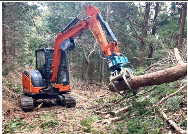
管理業務（倒木除去作業状況）
