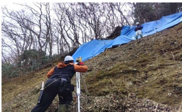
測量業務（林道法面崩壊地の測量状況）
