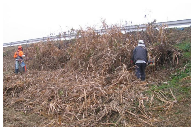
刈払機による除草作業
