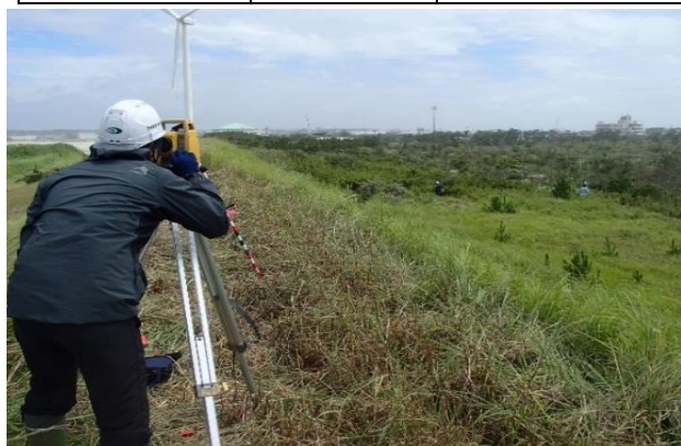
測量設計業務（保安林緊急改良事業）
