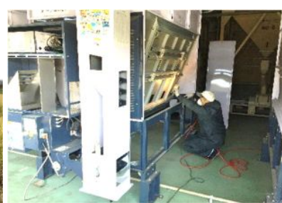
乾燥機分解清掃 （異品種混入防止対策）
