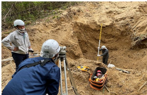
現場管理業務（牧場法面復旧工事）
