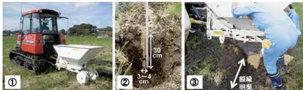
図 4 明渠と結合させた籾殻充填補助暗渠の施工 (①疎水材心土充填機を使用した施工作業、②施工後の土壌断面、③明渠と補助暗渠の結合部)
