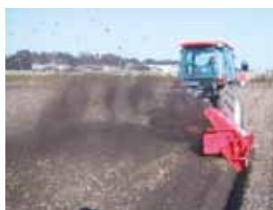
写真1 額縁明渠の設置
