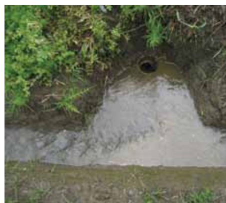
写真 2 明渠と排水路との接続
