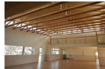
建築物の木造化・木質化
