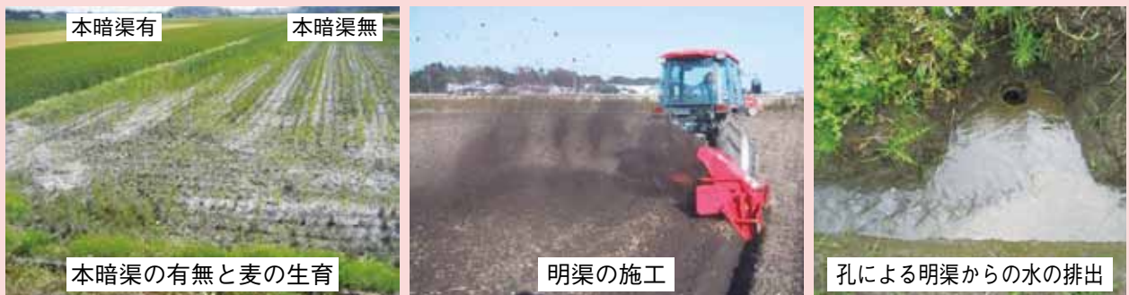
図2 暗渠および明渠
