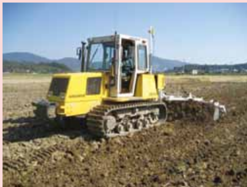
図 6 レーザーレベラーを使用した傾斜化均平作業
